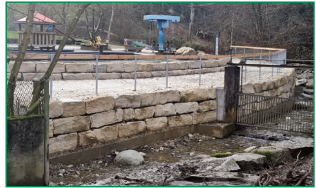
Neue Stützmauer und Geländer
